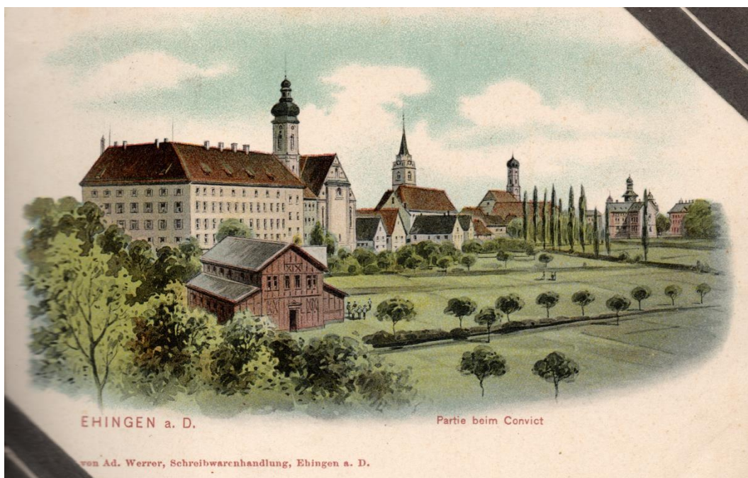
Das Konvikt mit der perspektivischen Abfolge der Kirchtürme : als Schlusspunkt der Turm der Post.
