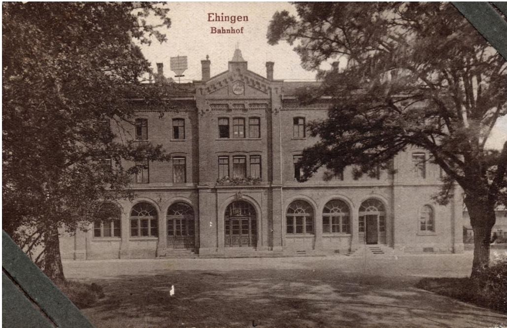
Der repräsentative Bahnhof, erbaut 1869, enthielt im Erdgeschoss Diensträume für den Bahnhof, eine Gepäckaufbewahrung, Wartesäle 1. und 2. Klasse, eine Bahnhofsgaststätte (Restauration). Im 1. Obergeschoss Büroräume der Bahnmeisterei und eine Wohnung für den Bahnhofsvorstand. Im obersten Geschoss weitere Wohnungen für Bahnbedienstete.
